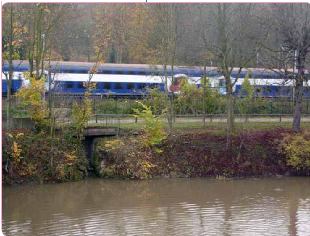
Vue de la berge prise depuis une maison de l'île de Migneaux
