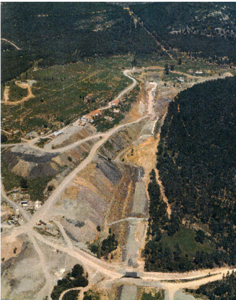
photo d'un chantier TGV (Madrid-Séville)
