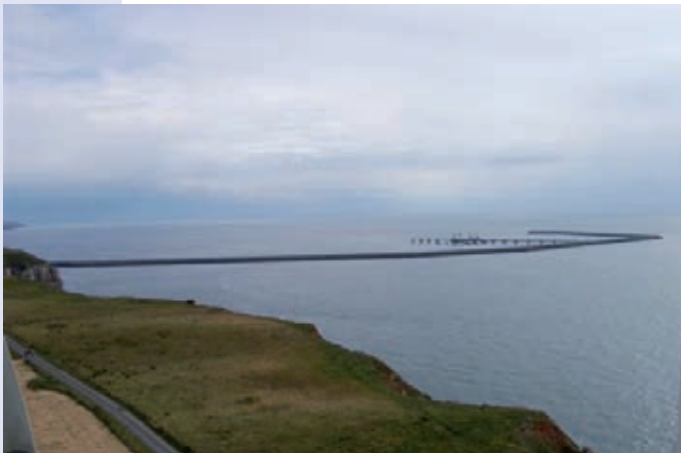
La digue du port pétrolier vue du phare de la Poterie
